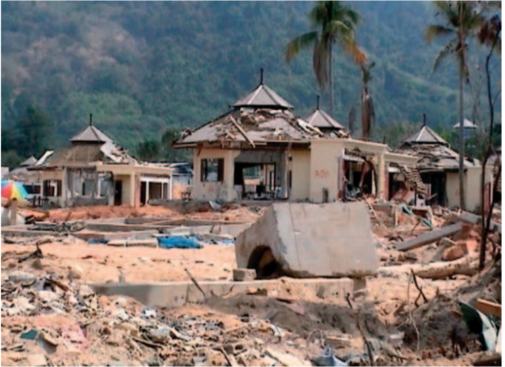
Abb. 2: Zerstörungen an Häusern und vor allem Dächern ermöglichen die Messung der Wellenhöhe, hier bei Khao Lak mit ca. +12 m über Hochwasserniveau.
