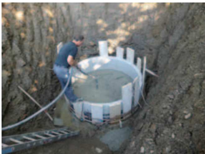
Abb 3: Bau des Schachtes für die GRSN-Station KAST (Kahler Asten im Sauerland), die vom Institut für Geophysik der Universität Münster und der BGR gemeinsam aufgebaut wurde. Die Betonschicht stellt eine gute Ankopplung sicher.
