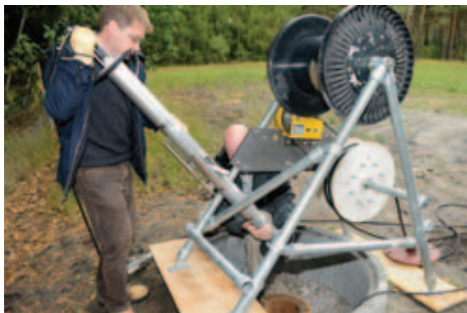
Abb. 4: Installation des Breitband-Bohrlochseismometers für die GRSN-Station KAST
