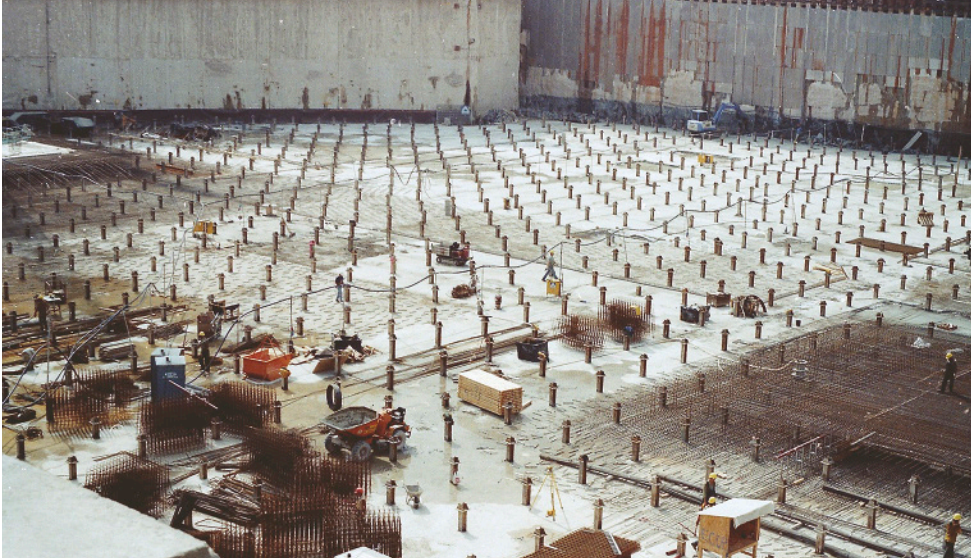
Die Baugrube Potsdamer Platz, Berlin im Jahre 1998 (Foto: H. Bock)
